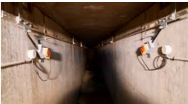
Moteur individuel par tringlerie guidée indépendamment
